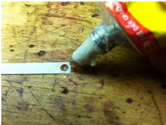
Abbildung 93: kleiner Tropfen Pattex drauf, dann Ventil auflegen, andrücken, ausrichten
